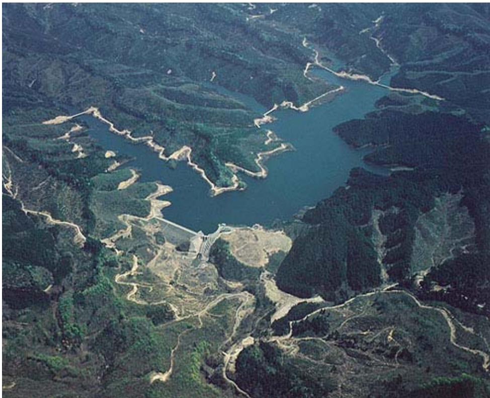
【農業用水を安定的に供給する小田川ダム】
