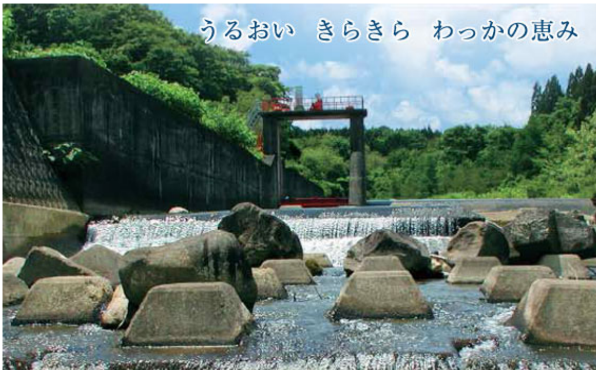
【改修予定の夏油頭首工】
