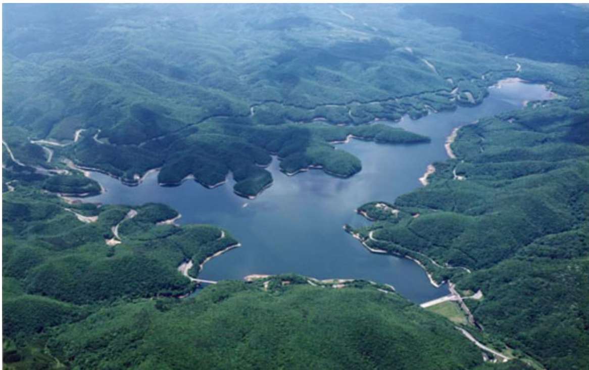
【農業用水を安定に供給する羽鳥ダム】
