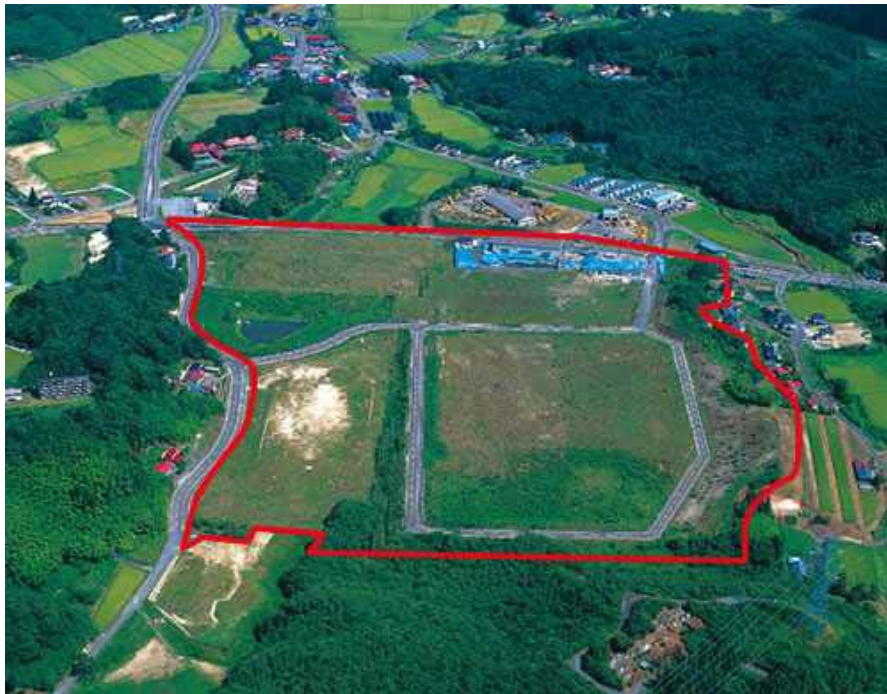
【大郷町エコファクトリー（一部）（川内流通工業団地）】
