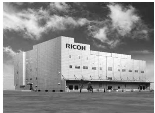
建設中のトナー工場
