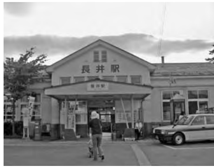
山形鉄道フラワー長井線鉄道「長井駅舎」
