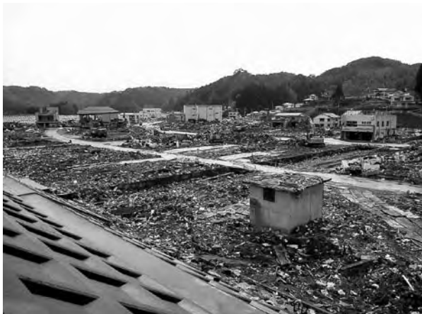
田老の堤防と被災地
