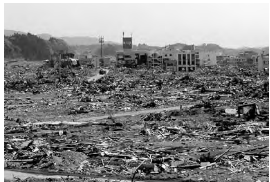
被災2カ月後の陸前高田市
