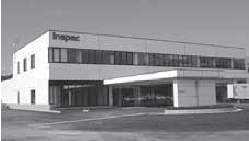
インスペック社屋外観 (インスペックより提供)
